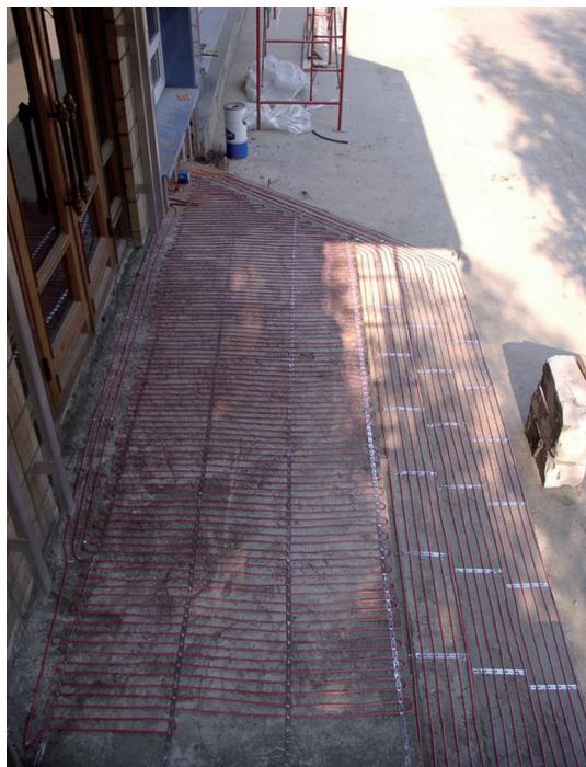
Фото 3. Монтаж системы снеготаяния на крыльце.
