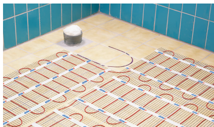
11. Продолжение укладки мата
