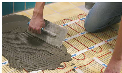
12. Затирка плиточным клеем
